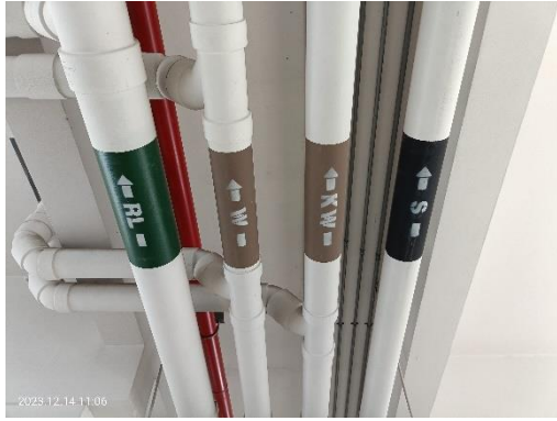
ท่อรวบรวมน้ำเสีย (KW W S)
